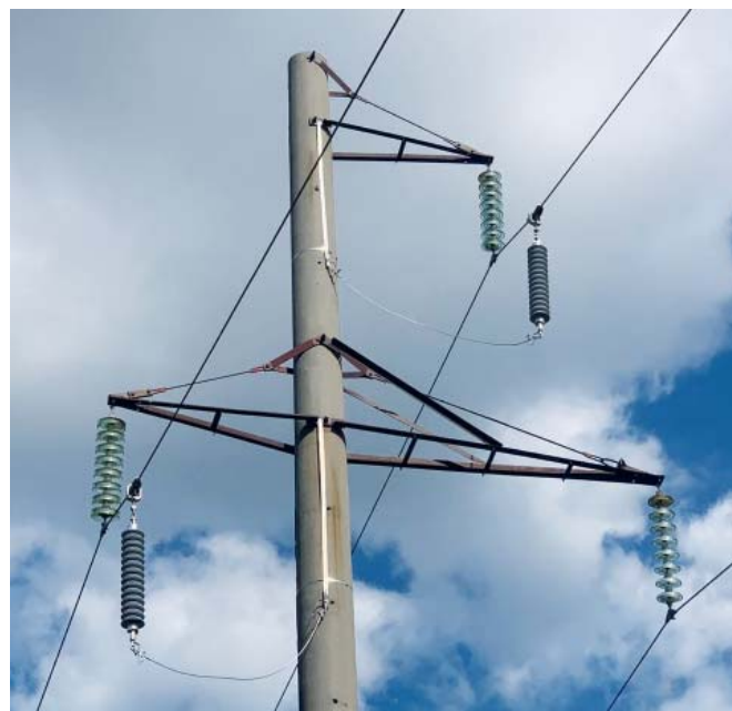
Рис. 4. Установка подвесных ОПН-110 на железобетонных опорах одноцепной ВЛ 110 кВ на верхнем проводе
