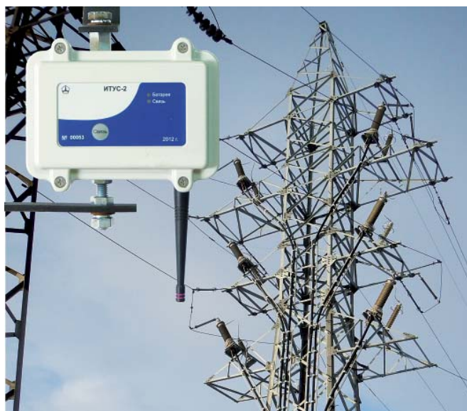
Рис. 4. Новая опора с ОПН 110 кВ в г. Челябинске с приборами контроля ИТУС-2 от ЗАО «Полимер-Аппарат» на кабельных вводах
