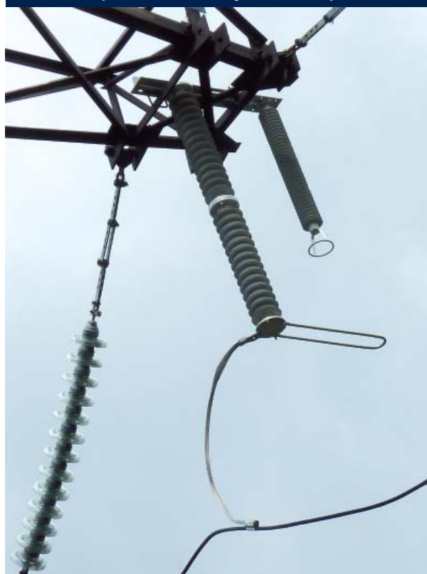
Рис. 10. Линейные разрядники на анкерных опорах с большим углом поворота
