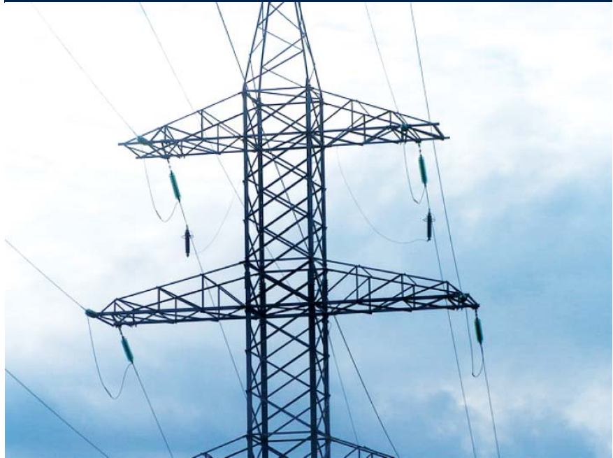
Рис 3. Применение линейных ОПН производства НПО «Полимер-Аппарат» вместо грозозащитного троса
