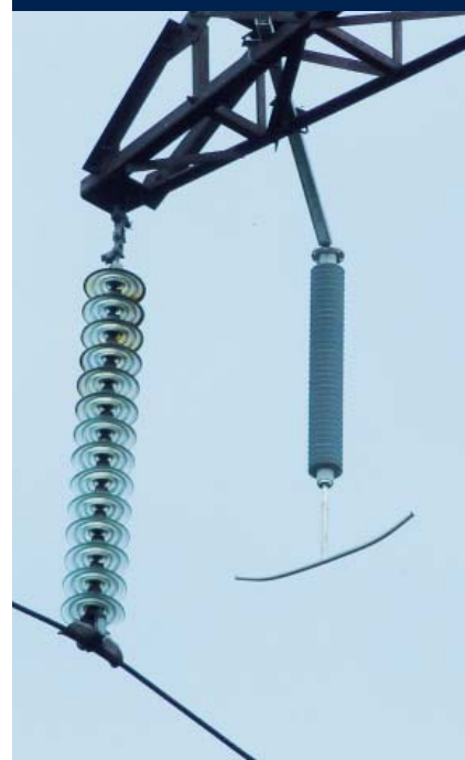
Рис. 2. Линейный разрядник РВЛ 220 кВ производства НПО «Полимер-Аппарат»
