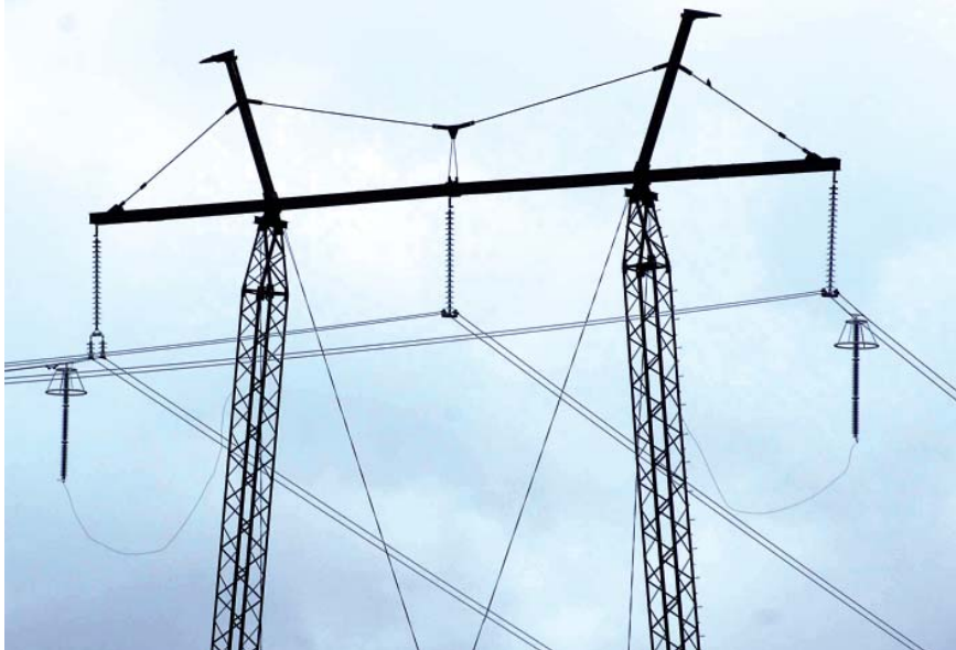
Рис 4. Линейные ОПН-330 производства НПО «Полимер-Аппарат»
