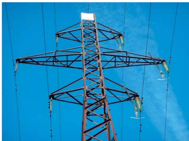
Рис. 5. Промежуточная опора ВЛ 110 кВ Варьеган — Бахилловская-1,2 с защитой разрядниками 2-й цепи
